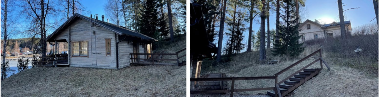
Tähtiniemen viimeisin rakennusvaihe on ollut vanhan rantasaunan paikalle vuonna 2002 rakennettu uusi rantasauna, johon liittyy myös laitur. Saunarakennus on lähellä rantaa huvilaan nähden alarinteessä ja kulku pihapiiristä saunalle on puisia portaita pitkin. (04/2025)
