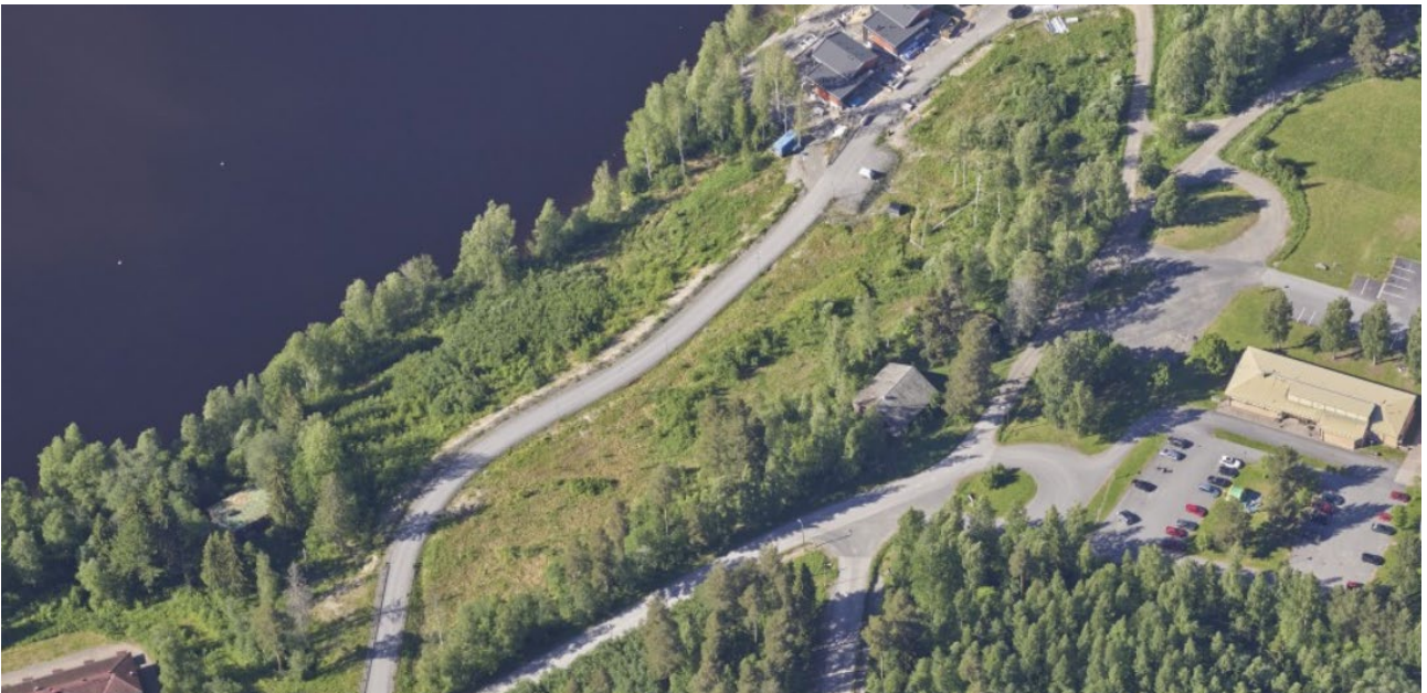
Viistokuva suunnittelualueen länsiosasta (2022). Kuvassa vasemmalla Päivänvarjontie 3:n tontti, jossa on vanha rakennus. Keskellä rakennettu Päivänvarjontie ja raivatut rakentamattomat omakotitalotontit. Etualalla Tähtiniementie, jonka tuntumassa on Tähtiniemen riipi. Kuvassa oikealla Alkio-opiston alue.
